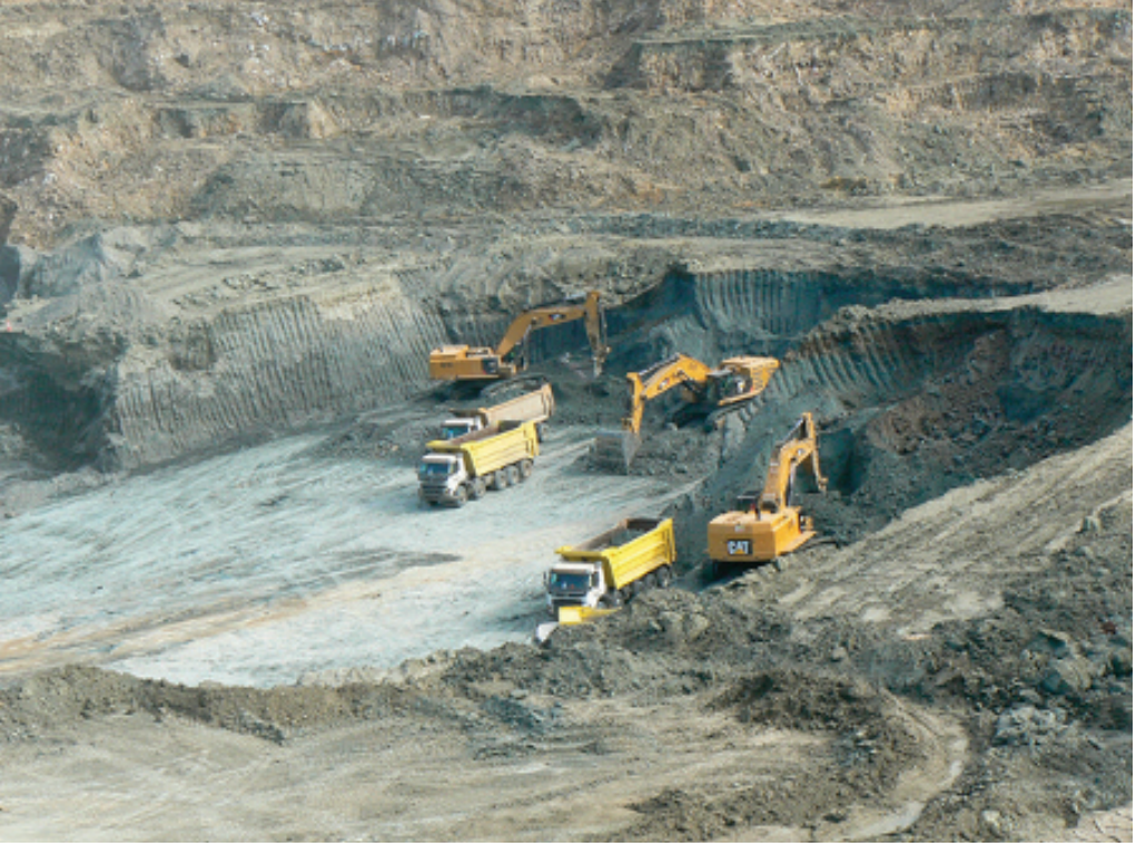
Fotoğraf 59.3. Havalimanı İnşaatı
