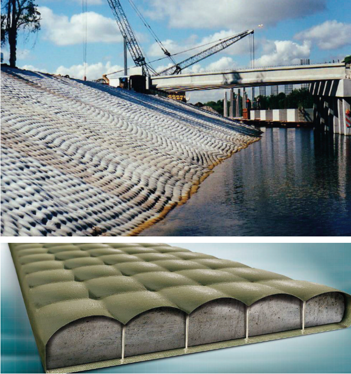
Şekil 28. Kanalın Yanal Yüzeyinde Planlanan Geosentetik Beton Şilte
